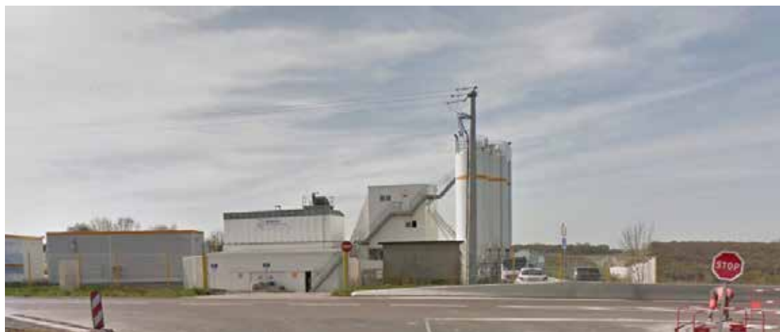
Centrale à béton pour les travaux de l'A150
